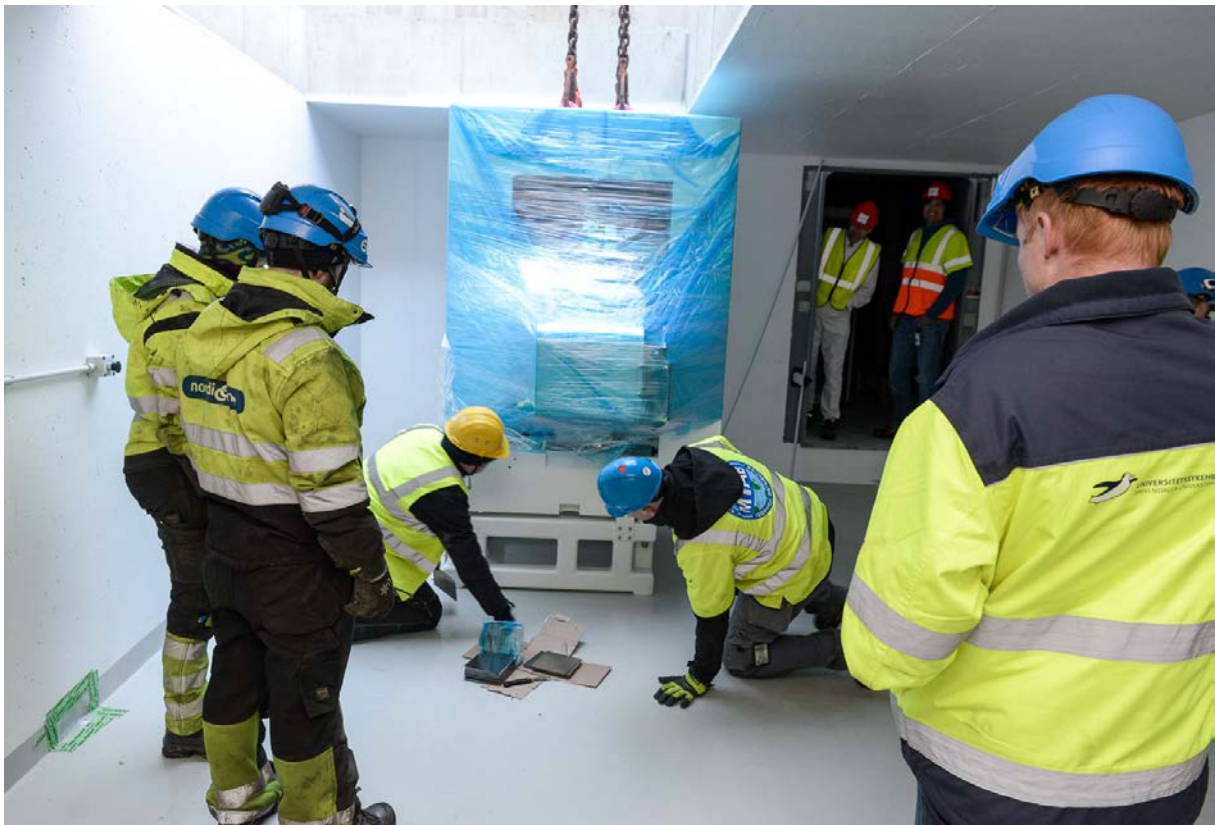
Syklotron heises på plass 25 april 2017
